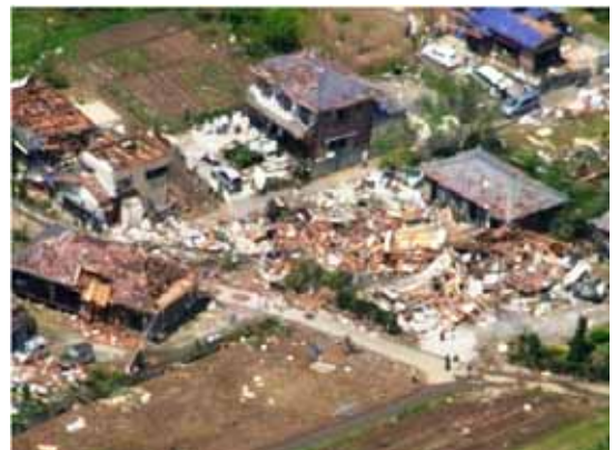
竜巻による被害状況（茨城県）
