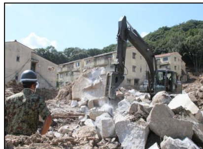
重機による岩石の掘削
