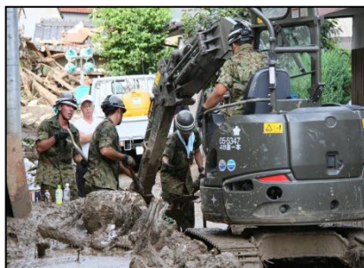
重機による土砂撤去
