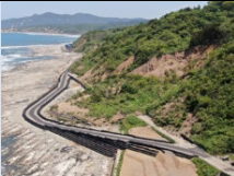
国道 249 号輪島市 千枚田工区
