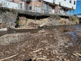
大雨で被災した河川護岸 (輪島市塚田川)
