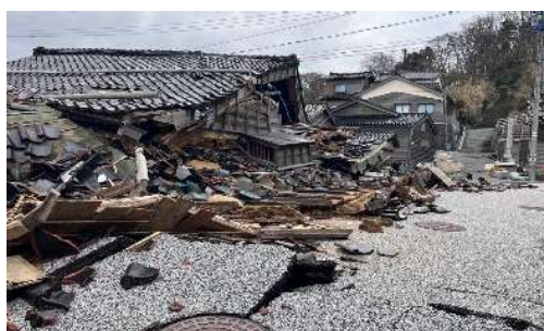
【旧角海家住宅(重要文化財)】
