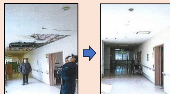
介護施設の復旧の様子
