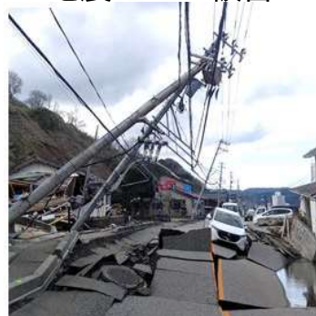
地震による被害
