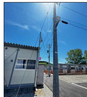
仮設住宅への整備
