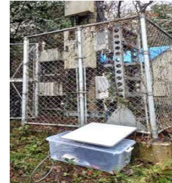
可搬型衛星アンテナ
