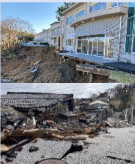
旧角海家住宅(重要文化財)
