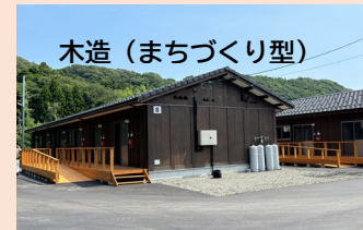
木造(まちづくり型) 応急仮設住宅 珠洲市：旧日置中学校グラウンド
