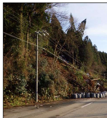
ケーブルの復旧
