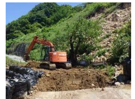
崩落土砂撤去（農地地すべり）（輪島市）
