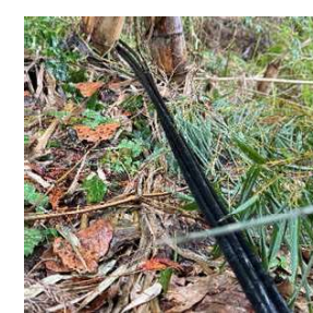
ケーブル網の応急復旧 (地面敷設)
