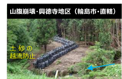
大型土のう設置
