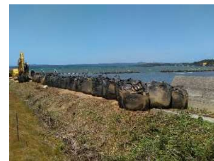
大型土のう設置（農地海岸）（七尾市）
